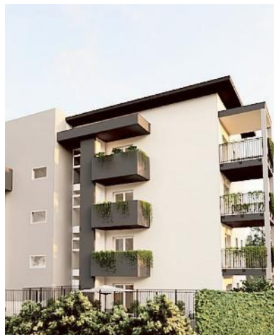
▲ Svolta ecologica Uno degli edifici che compongono Savoneragreen
